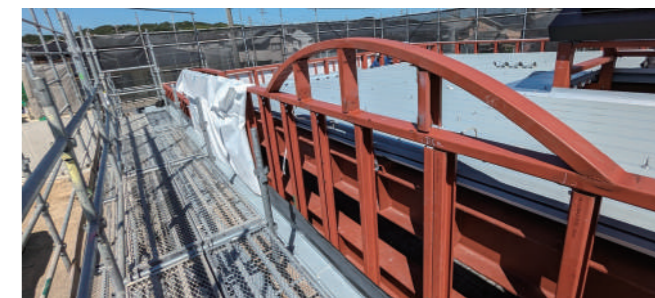
▲看板下地工事
